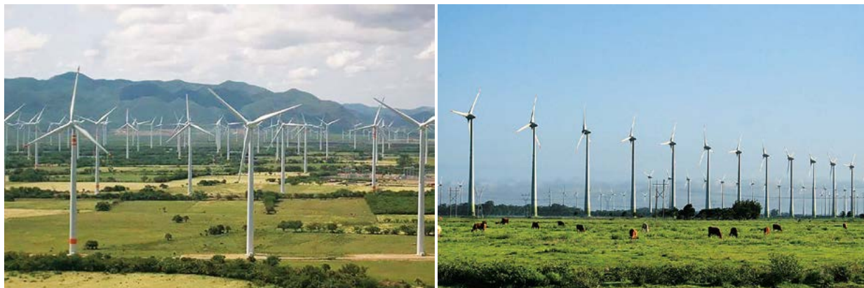
Figura 3. Aerogeneradores instalados en el ejido de la Venta, Juchitán, Oaxaca. Fuente: Tomado de http://www.amdee.org/Amdee/AMDEE_presentacion_esp.pdf
