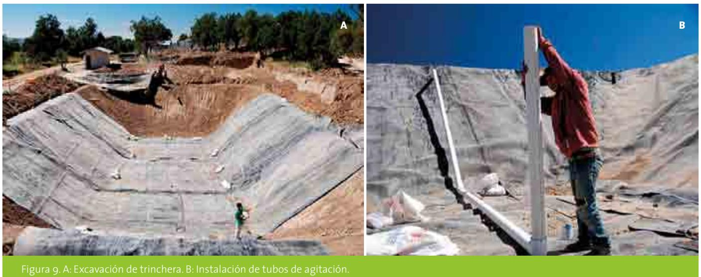
Figura 9. A: Excavación de trinchera. B: Instalación de tubos de agitación.
