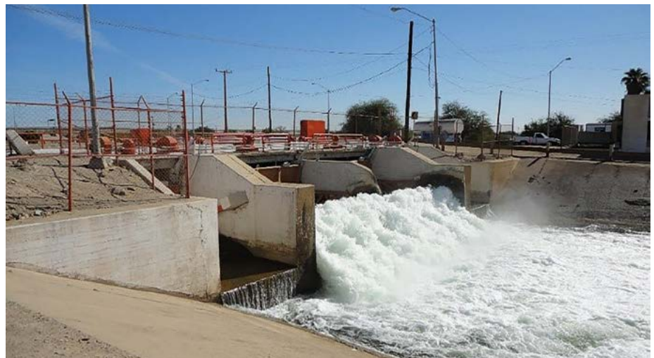
Figura 1. Estructura de control Canal Reforma km 27+000.
