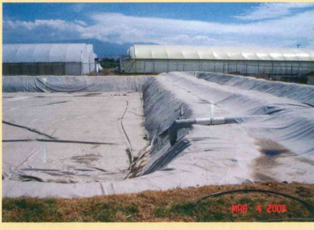
Figura 5. COLPOS 5. Cisterna para riego en invernaderos.
