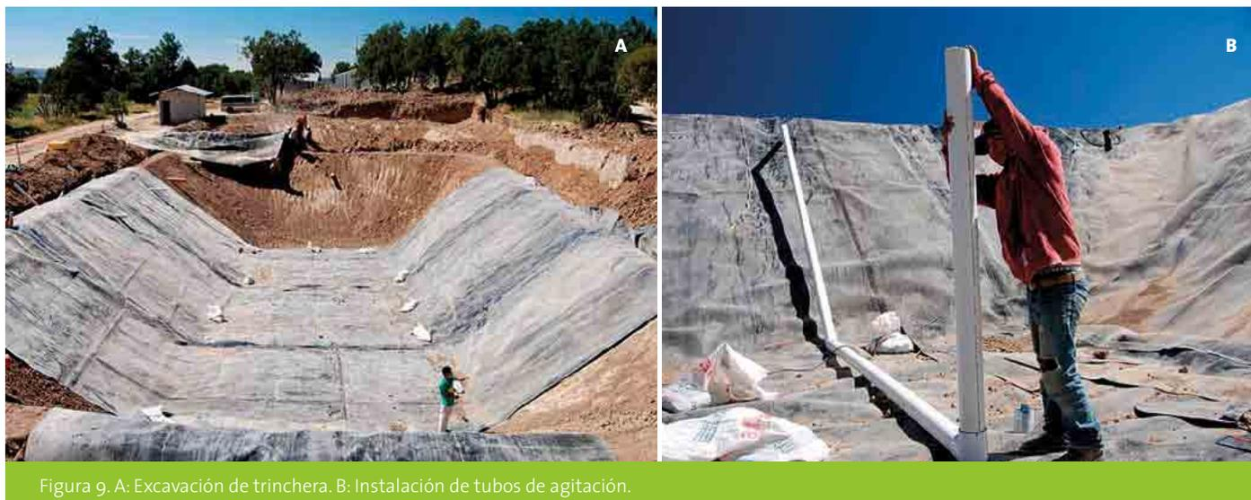
Figura 9. A: Excavación de trinchera. B: Instalación de tubos de agitación.
