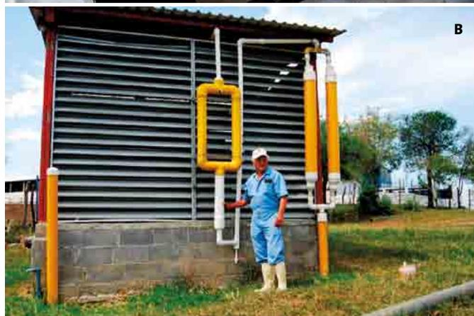
Figura 10. A: Motogenerador a base de biogás de la granja María Ana. B: Filtros colocados verticalmente y trampas de agua.
