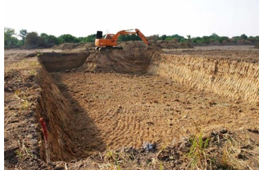
Figura 2. Cuenca de captación de agua de lluvia (izquierda) y Excavación para el almacenamiento del agua de lluvia (derecha).
